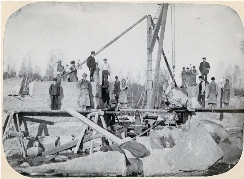
Bygget av en vägport vid Skägga söder om Tranås, fotograferat i november 1873.
